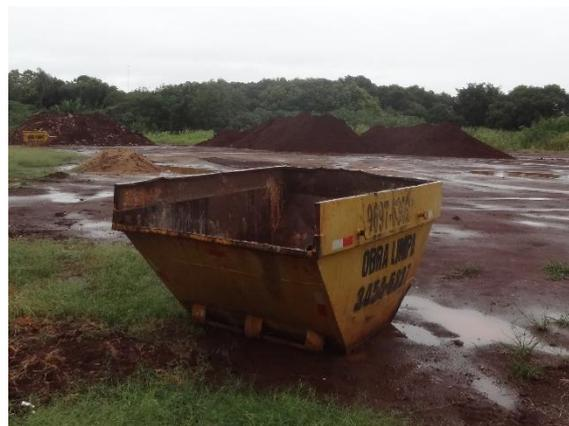
**Figura 45 - Caçambas para acondicionamento de RCC.**
